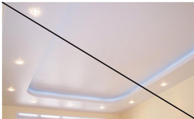
Плохо Многоуровневые гипсокартонные конструкции
