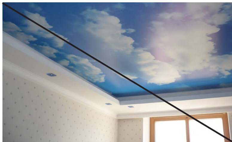
Плохо Натяжные потолки. Потолки с рисунками
